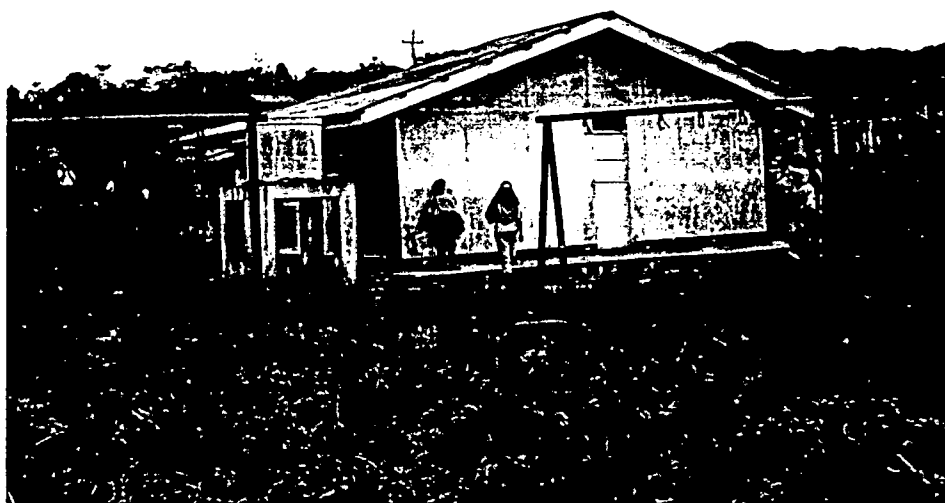
Foto 16. Posta Sanitaria de Quincha Prefabricada, sin daño alguno. Rioja, Abril 1991
