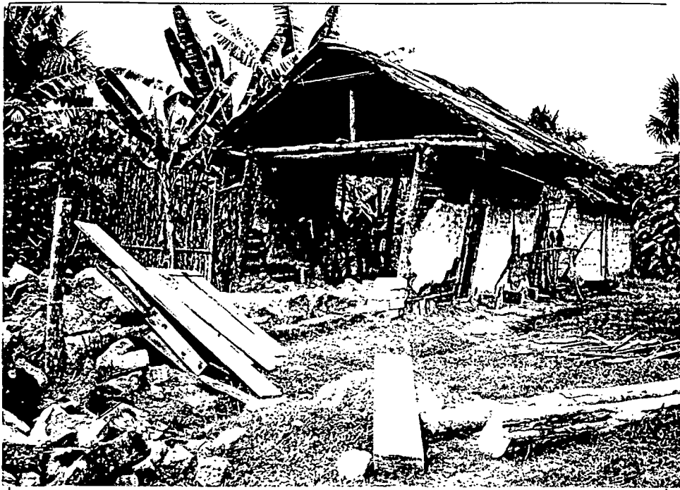
Foto 12. Vivienda de quicha tradicional, inclinada por los efectos del sismo y su mala construcción: - Postes principales colocados superficialmente (a menos de .70 m.). - Construcción hecha en terreno húmedo, sin drenaje apropiado. Rioja - El Porvenir, Mayo 1990.
