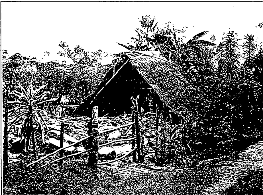
Foto 6. Vivienda con paredes de tapial totalmente colapsados y techo de palmera intacto.
