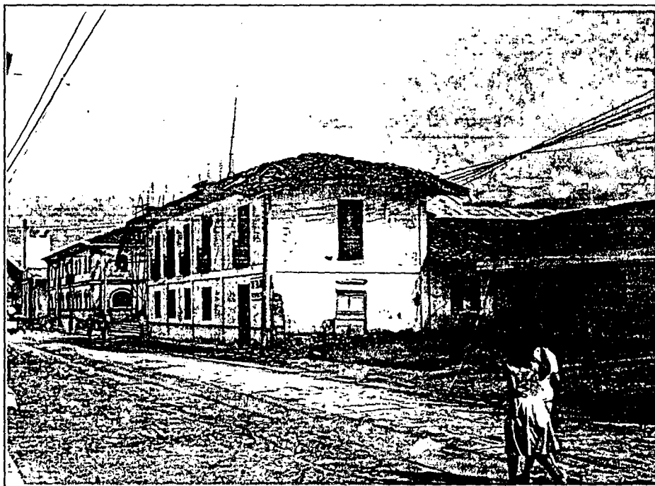
Foto 35. Local de la Prefectura de Moyobamba (1991). Vista que muestra la fachada frontal derecha y la parte posterior, en cuyas paredes no se observan daños de consideración. - Los daños en el techo son por el deterioro de las maderas (debido a la humedad o presencia de termitas). Moyobamba, Abril 1991.
