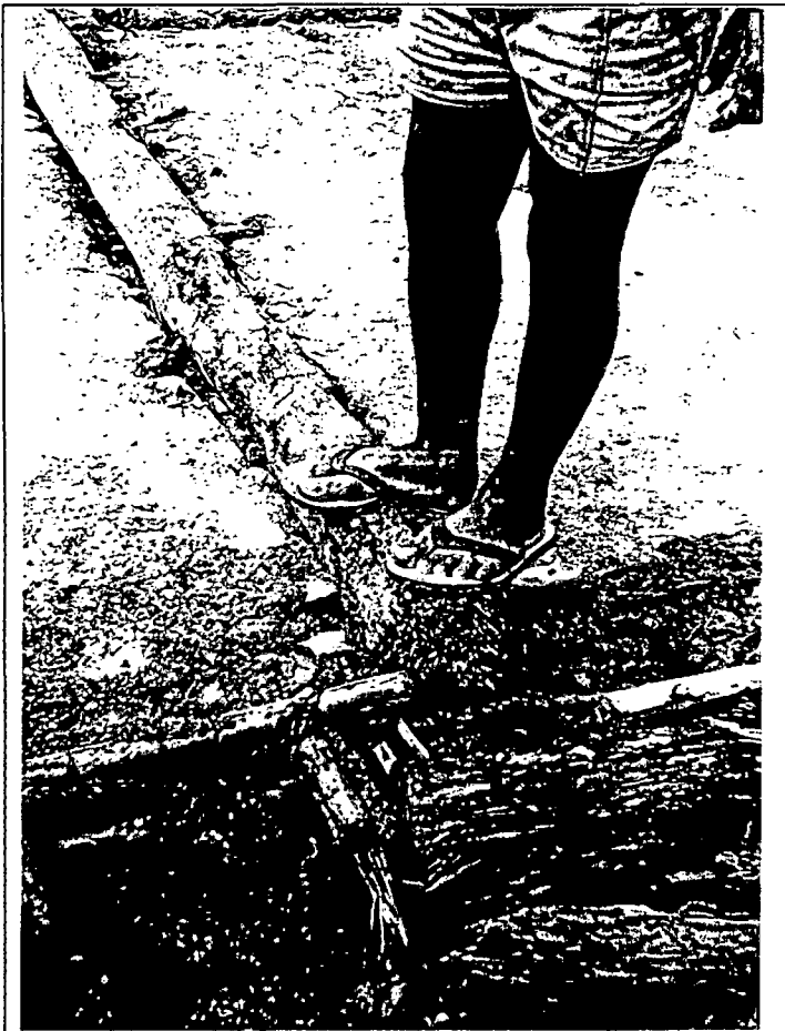
Foto 13. Pared de quicha tradicional, volteada por los efectos del sismo y el deterioro por intemperismo del poste principal. - Poste principal de mala calidad y madera inapropiada. - Construcción hecha en terreno húmedo, sin drenaje apropiado, que deteriora rápidamente la madera y hace perder su resistencia y ductilidad. Moyobamba, Abril 1991.
