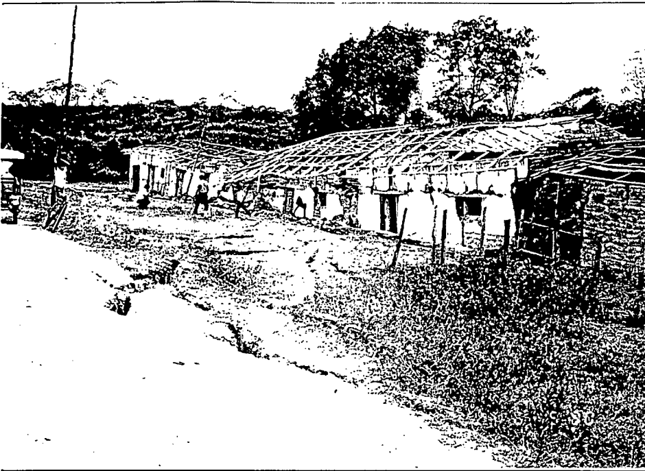
Foto 5. Grietas en la superficie (0.40 m. de ancho por 150 m. de largo aprox.); viviendas hundidas y colapsadas por el fenómeno de Licuación de Suelos .
