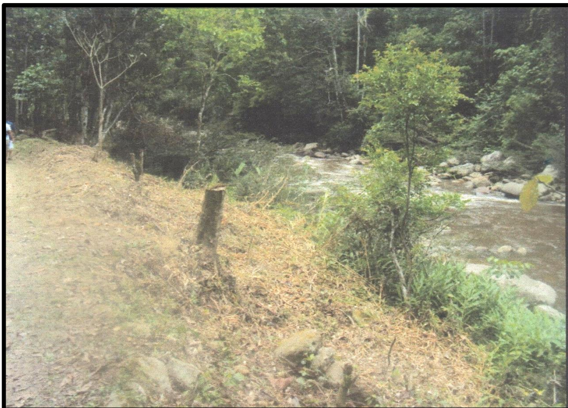
Foto 5. Se aprecia el lugar elegido para el emplazamiento de la presa del Micro embalse.
