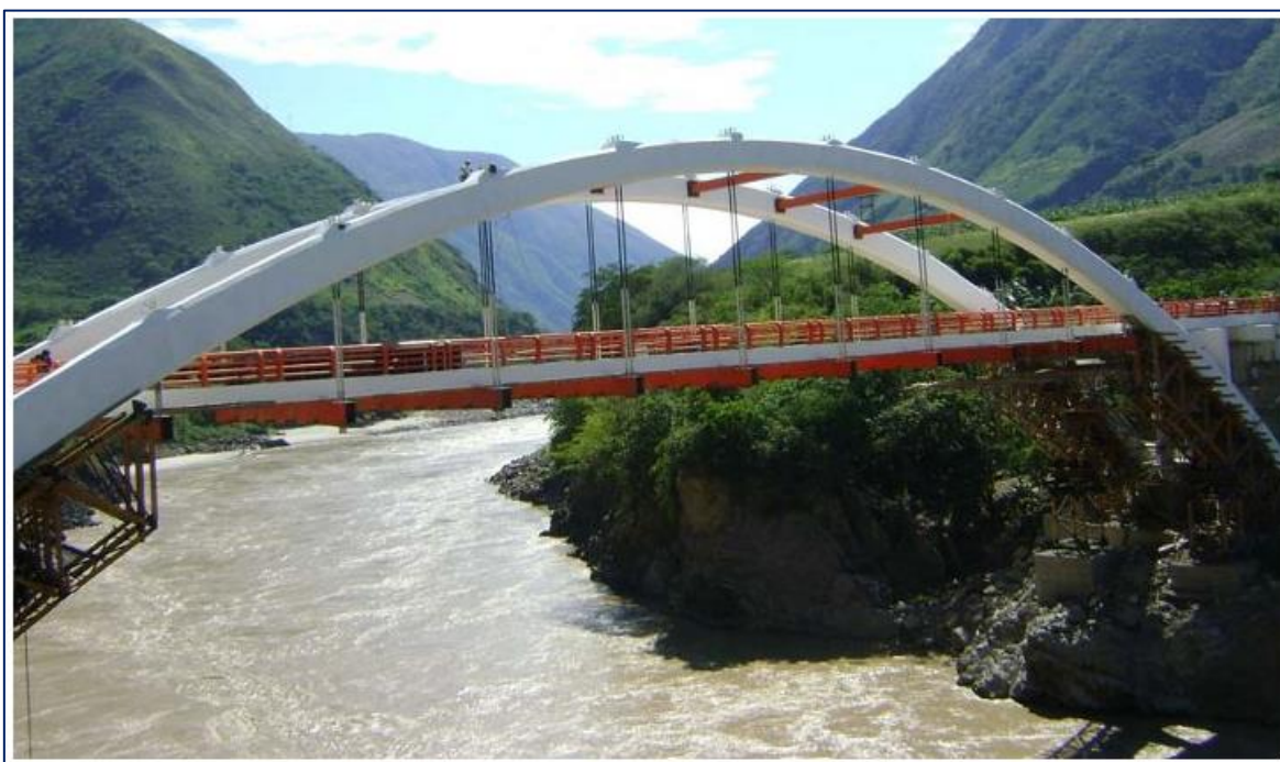
Figura 20: Puente Salinas - Amazonas de Tablero Inferior. (Fuente: Elaboración propia)
