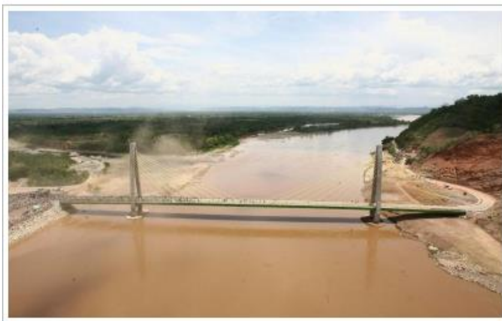
Figura 22: Puente de Bellavista – Región San Martín- Perú. (Fuente: Elaboración propia).
