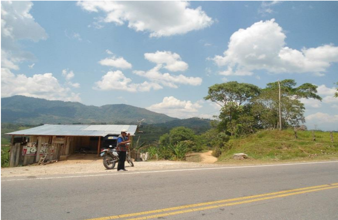
Fotografía N°05: Punto final del tramo en estudio, EMP.PE-5N (Caserío San José del Morro), km 05+364.00.
