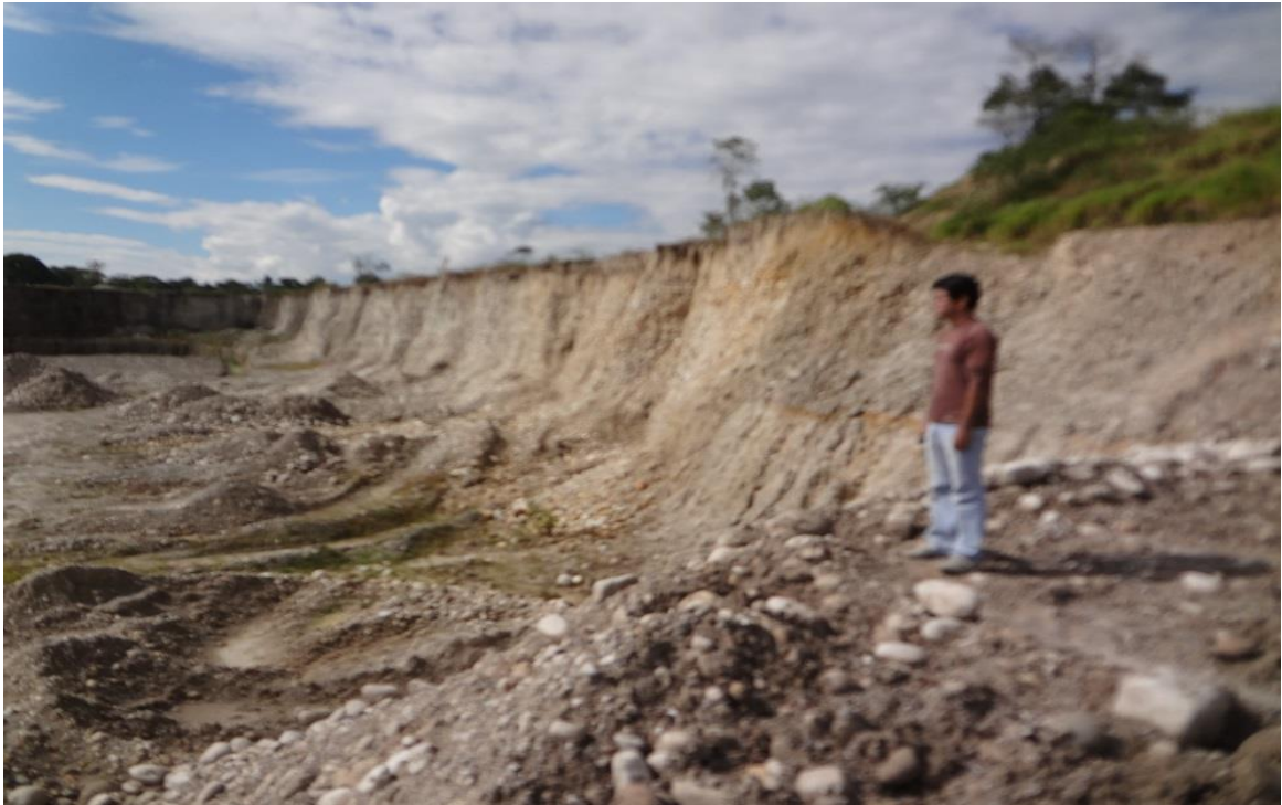
Fotografía N°09: Se comprobó in-situ el color textura y calidad de material, para ser utilizado en la capa de afirmado, corroborando a lo que dice el estudio de mecánica de suelos.
