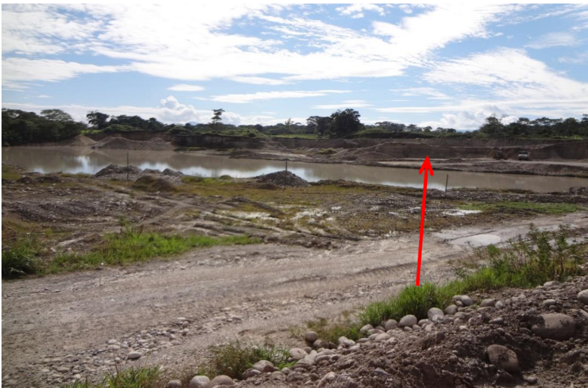
Fotografía N°10: En la Actualidad la Cantera Garate, posee material seleccionado listo para ser utilizado.
