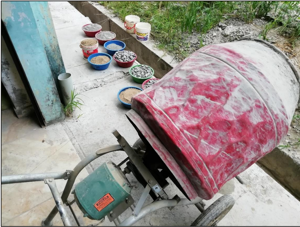
Foto 17: Proceso de mezclado del concreto.
