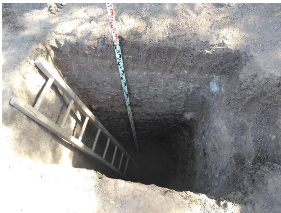
Midiendo la profundidad de la calicata
