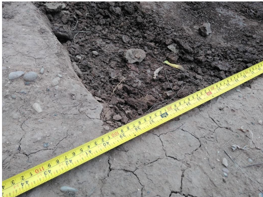
Verificando el ancho de la calicata
