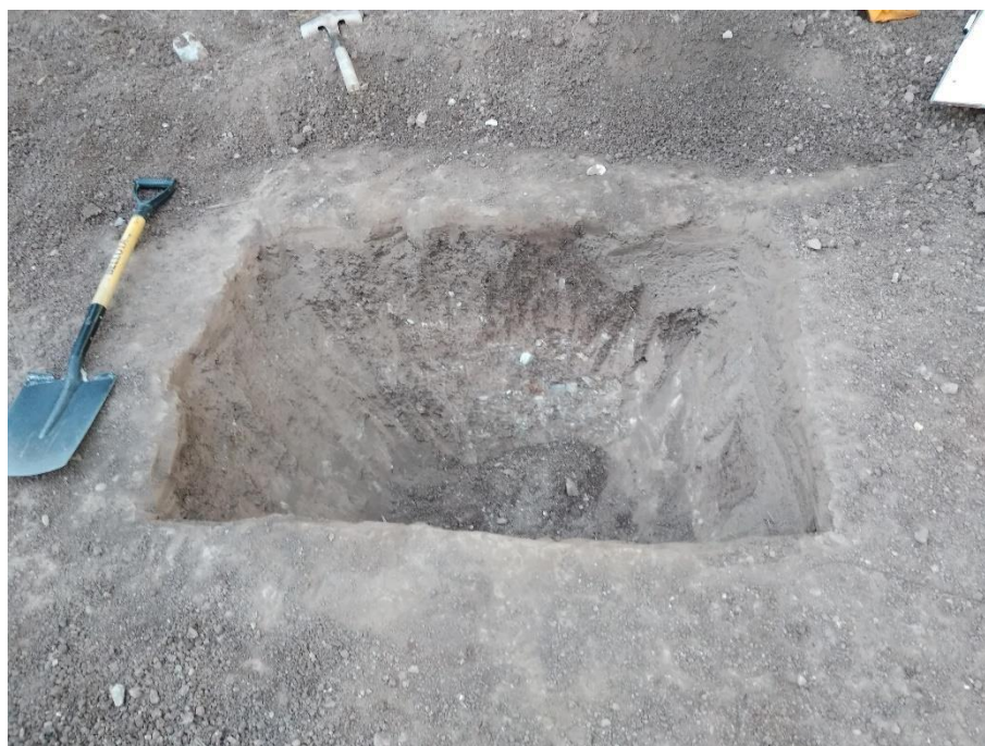
Empezando con la excavación de la calicata
