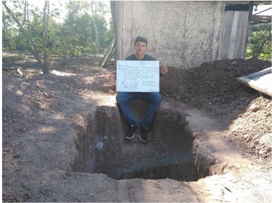
Calicata N° 10 finalizada de excavar
