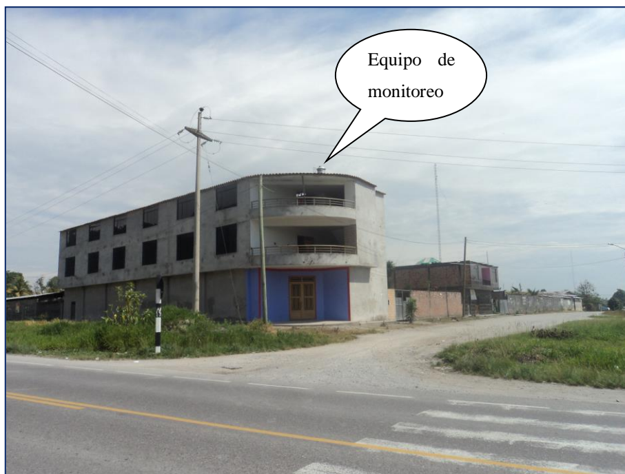
Fotografía 9. Equipo ubicado a 8 mt en azotea de vivienda.
