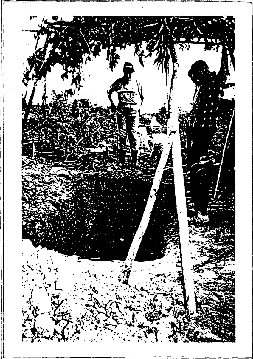
CALICATA PARA ESTUDIO DE SUELOS
