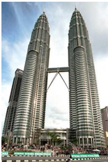
Figura 17: Torres Petronas, Kuala Lumpur Malasia 1997. Una expresión del uso del Concreto de Alto Desempeño.
