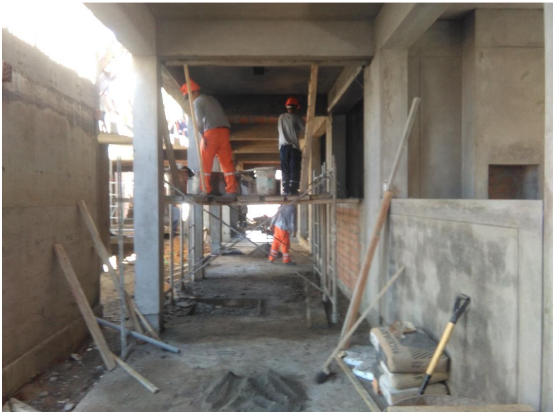
Cielorraso con mezcla: cemento - arena
