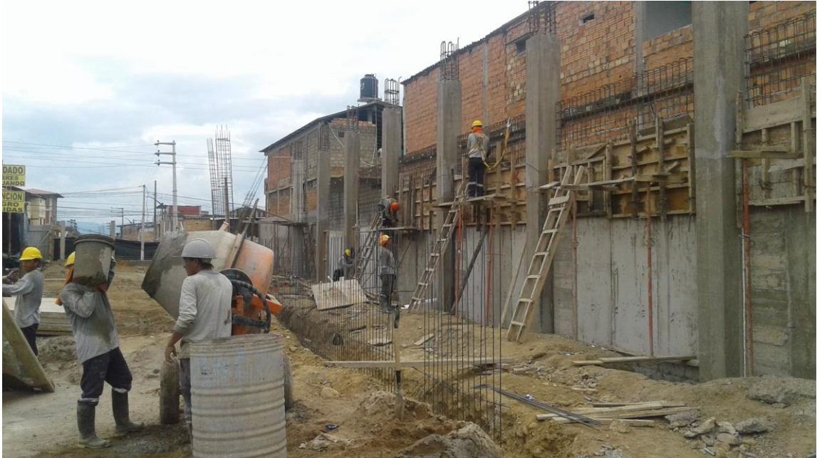
Encofrado y Vaciado de concreto en Muros reforzados
