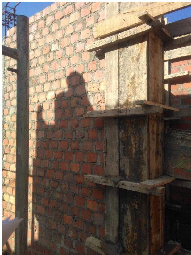
Muro de ladrillo K.K. de arcilla 9x13x24 cm. Asentado de cabeza
