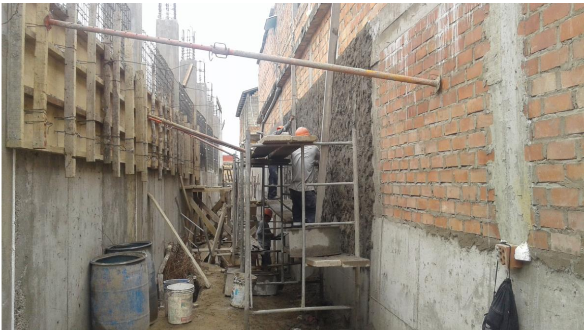
Tarrajeo de Cerco Perimétrico
