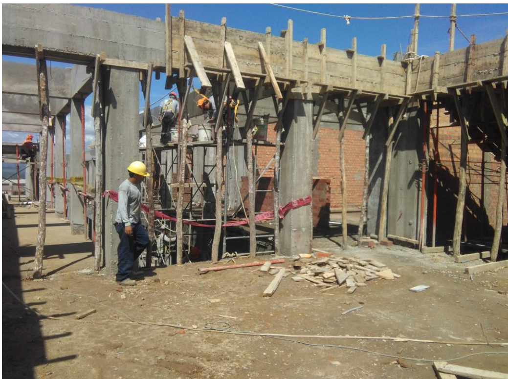
Encofrado de Vigas
