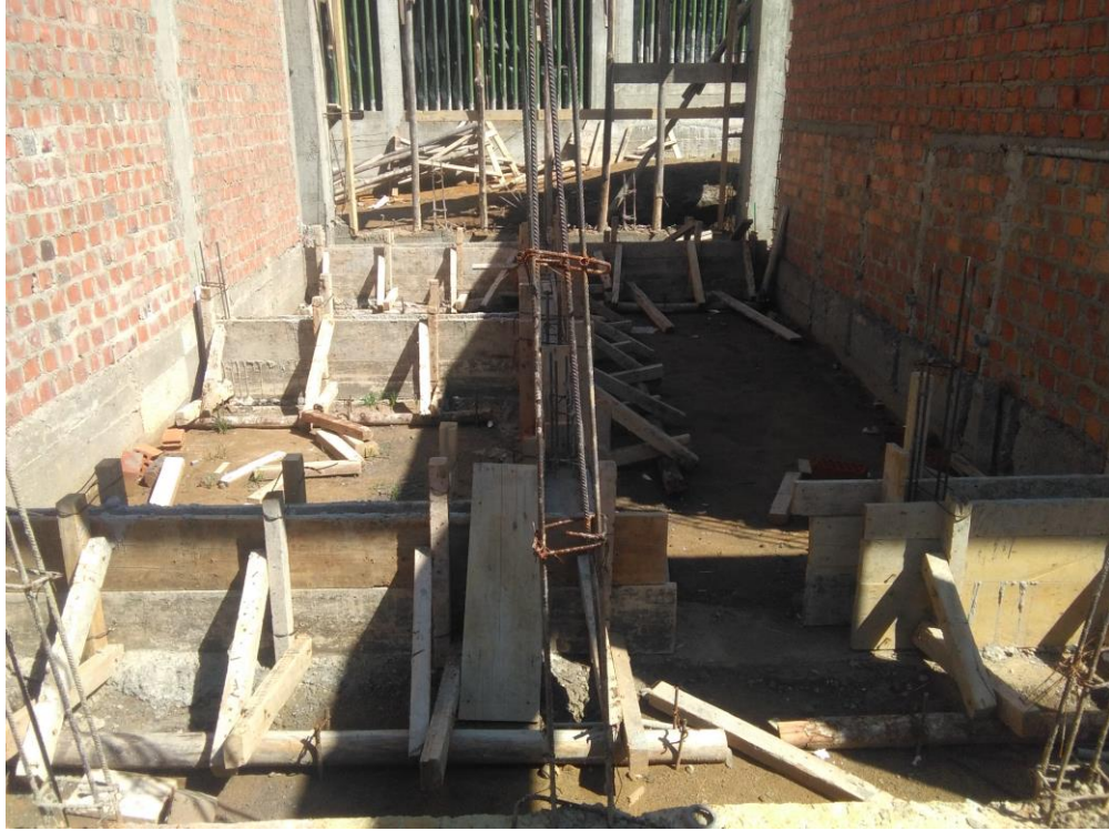
Encofrado de sobrecimientos
