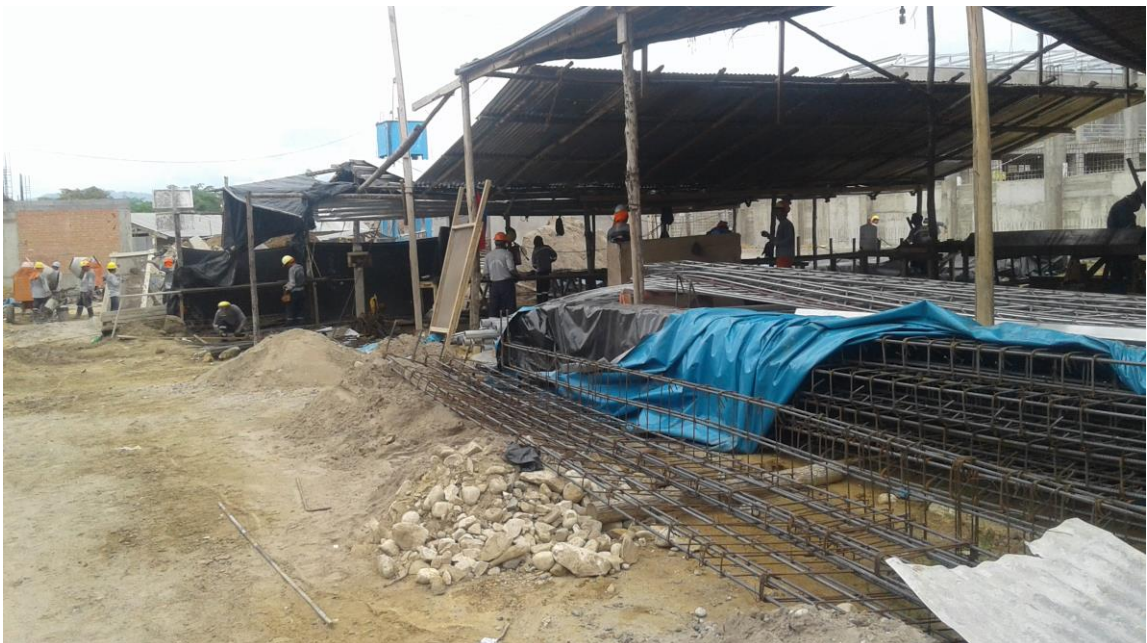
Habilitación de Acero para partidas de Concreto Armado
