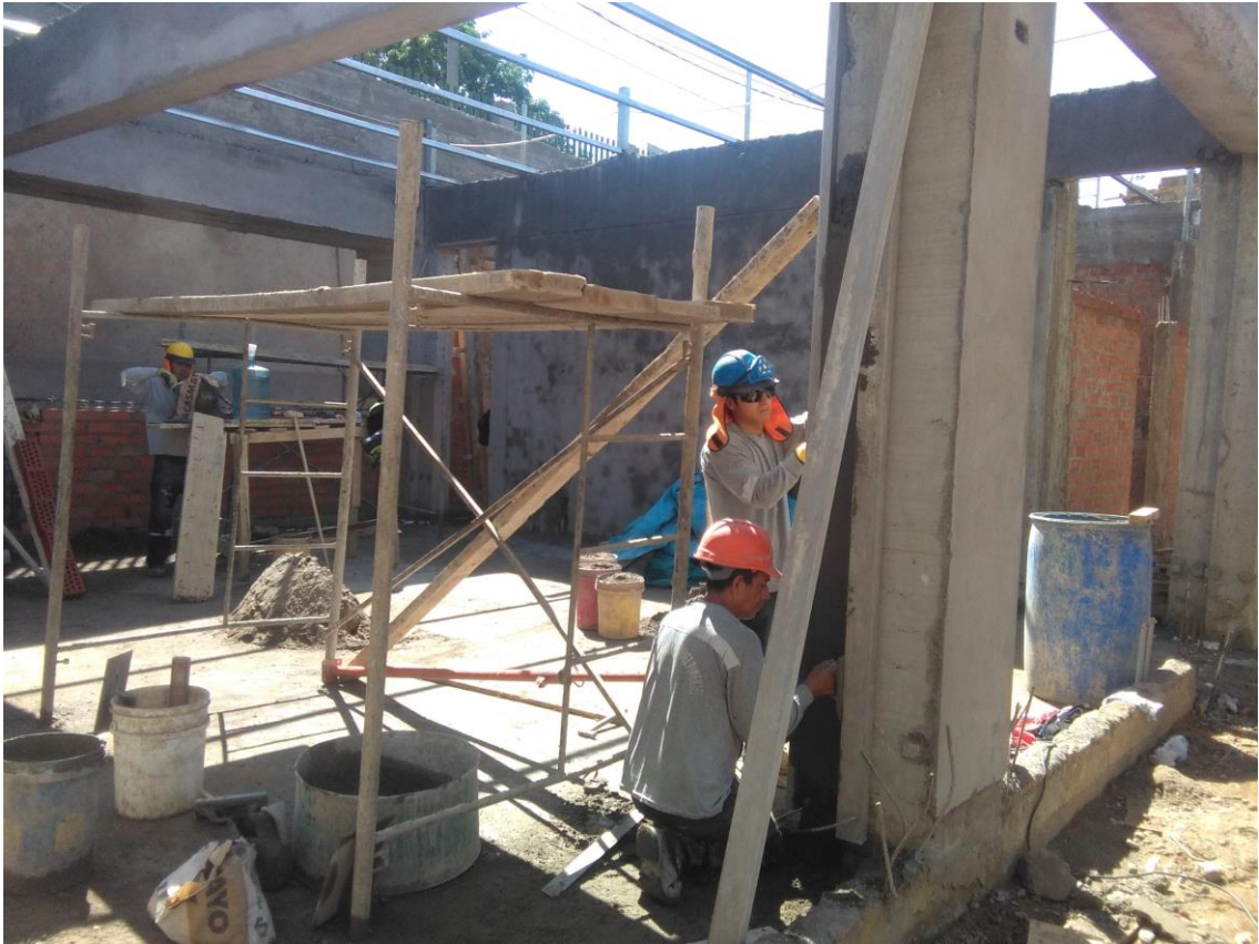
Tarrajeo de Columnas
