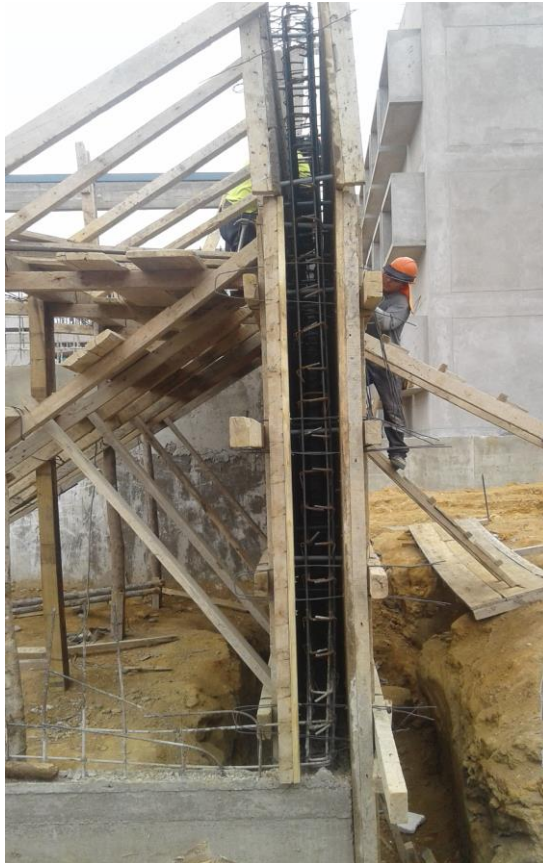
Encofrado de Columnas
