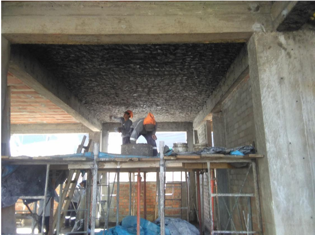
Cielorraso con mezcla: cemento - arena
