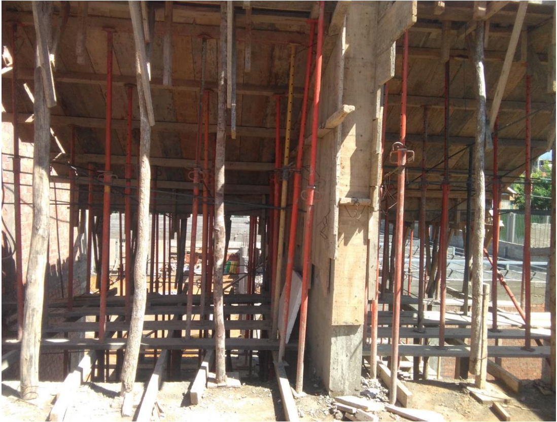
Encofrado de Losa maciza
