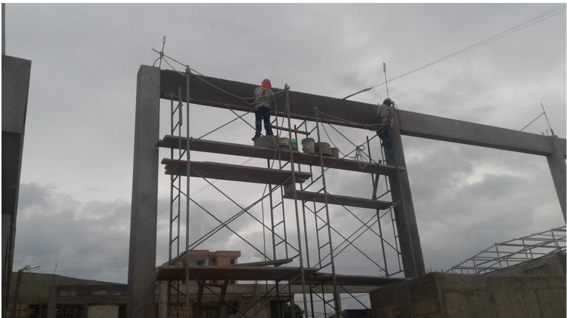
Tarrajeo de Vigas
