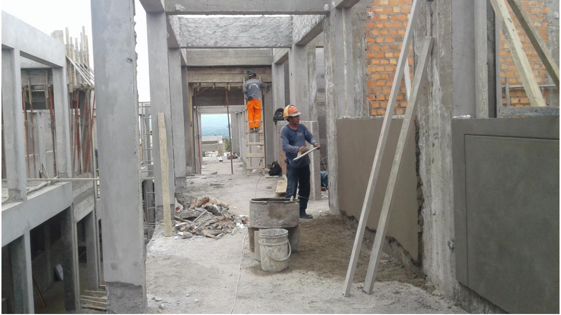
Tarrajeo de Muros Interiores
